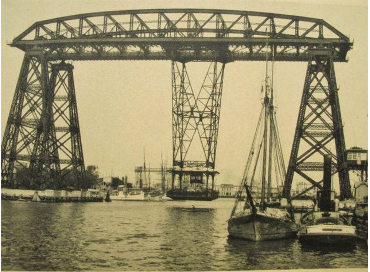
Puente terminado - Imagen de la Época - 1914
