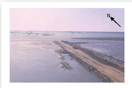
A la altura del Paraje El Laurel la RP n° 1 (Santa Fe) cede ante la presión de las aguas. Varios km de capa asfáltica fueron quebrados y transportados por la corriente.
