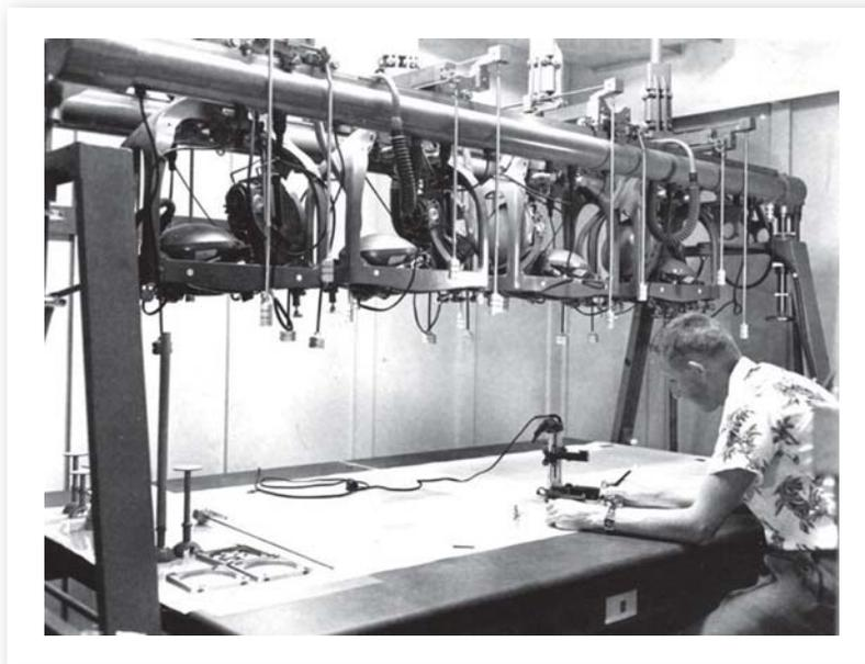
Un instrumento de trazo estereoscópico Twinplex para recopilar información de mapas de pares de fotografías aéreas. División topográfica, Servicio Geológico de los EE.UU. Condado de Sacramento, California. 1957. [Fotografía de USGS. Archivo de imagen: [/htmlib/btch331/btch331j/btch331z/pef00223.jpg](http://htmlib/btch331/btch331j/btch331z/pef00223.jpg)]
